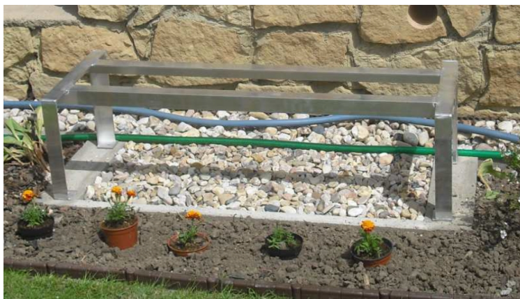
Rysunek 8: Przykład wykonania fundamentu pod pompę ciepła
